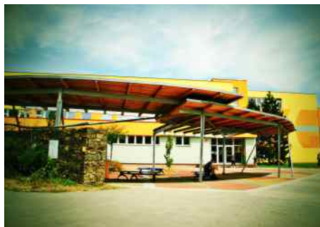
Prostor před ZŠ 17. listopadu na sídlišti Sever.
