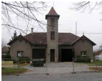
Hasičská zbrojnice před a po rekonstrukci.
