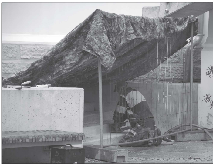
Schodiště v průčelí Ringhofferovy vily prochází v těchto dnech opravou v rámci záruky.
