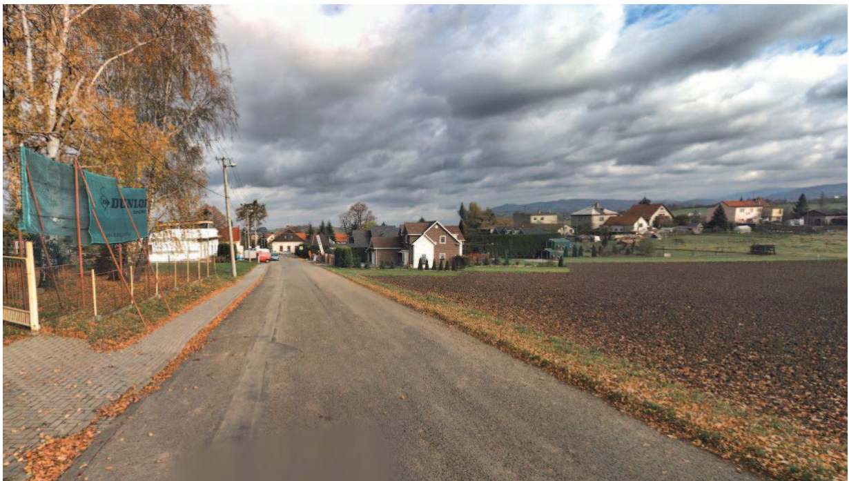
Pohled na zástavbu od západu k autobusové zastávce U Simprů ( www.cuzk.cz ).
