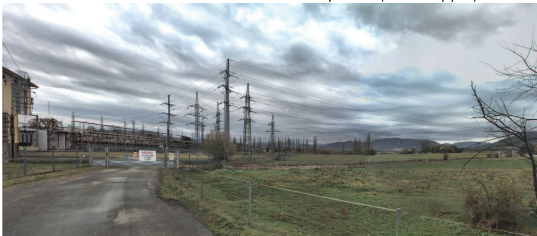
Obr.: Souběh vedení 110 kV a 22 kV v okolí rozvodny Příbor ( www.mapy.cz )
