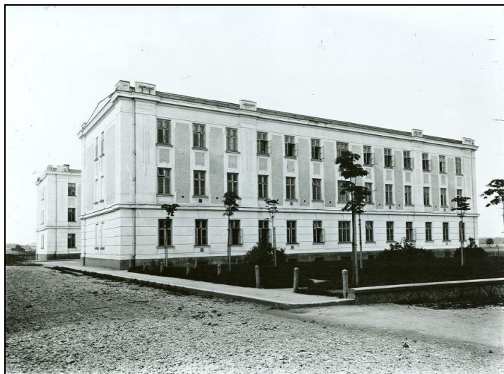
Objekt „Kasárna“ na ul. Česká č.p. 318
