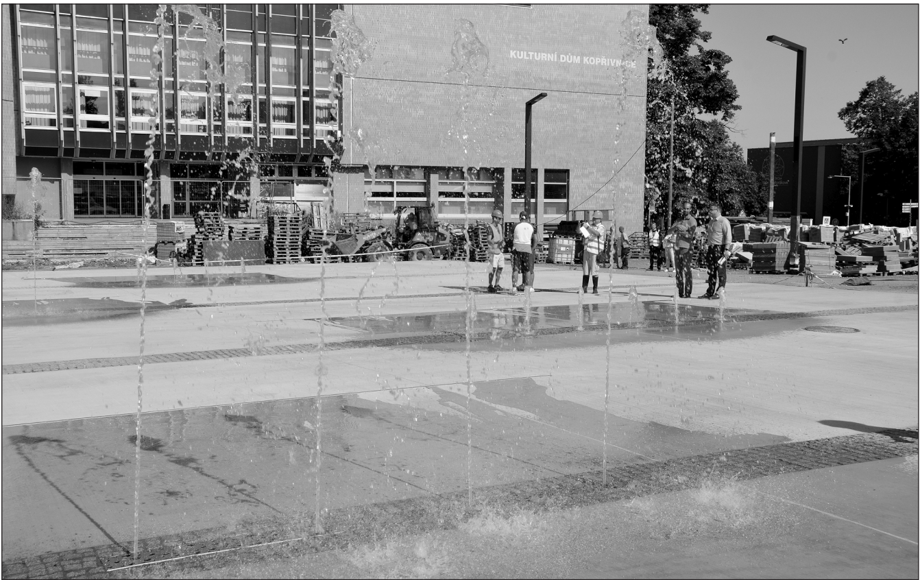
Práce na revitalizaci centra stále pokračují. Přestože do konečného termínu zbývají necelé dva týdny, objednatel zatím nepřevzal ani objekty, které měly být dokončeny v červnu. 20. 7. proběhla zkouška vodních prvků v prostoru před KDK. FOTO: DAVID MACHÁČEK
