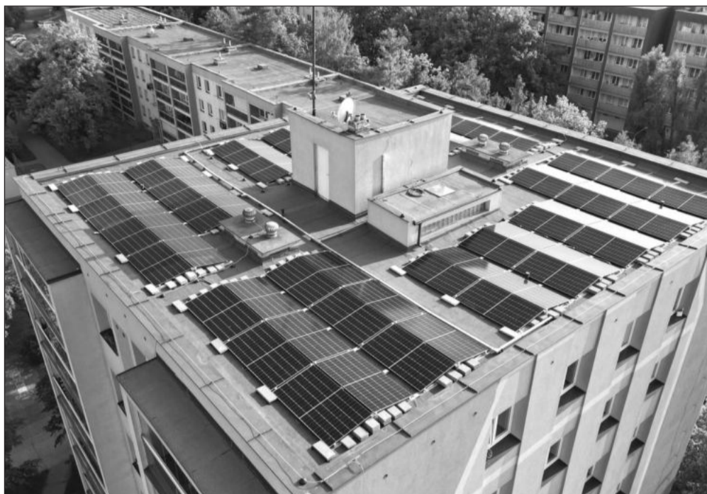
Na střeše bytového domu č. p. 1186 na ulici Francouzské je v provozu fotovoltaická elektrárna o výkonu 38 kWh. FOTO: BD FRANCOUZSKÁ 1186
