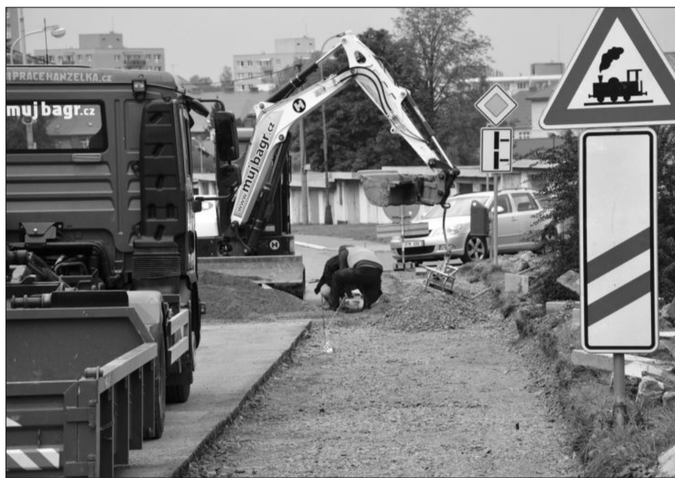
Po dokončení výstavby chodníku bude zahájena oprava povrchu komunikace na ulici Husově, která si vyžádá kyvadlový provoz řízený semaforem. FOTO: DAVID MACHÁČEK
