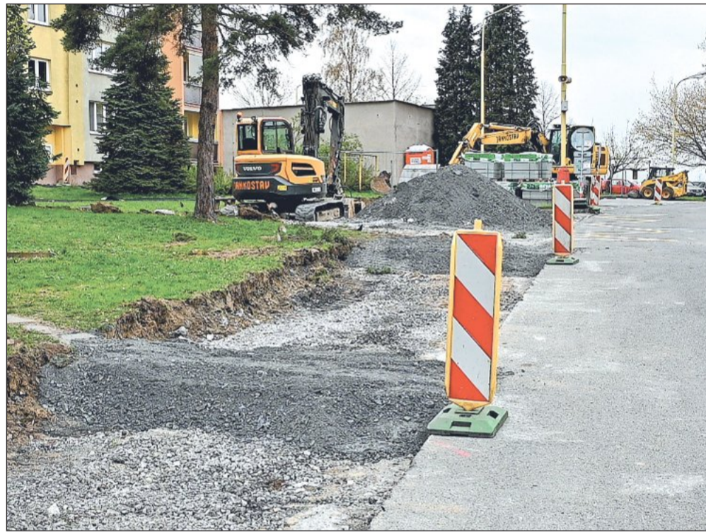
Budování nových chodníků na ulici Polní je jednou z akcí, které zkomplikovaly parkování v lokalitě. To by mělo v budoucnu zlepšit nové dočasné parkoviště. FOTO: DAVID MACHÁČEK
