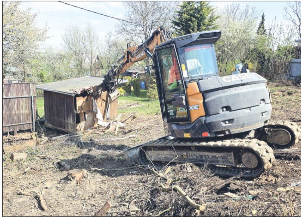
V závěru minulého týdne šla k zemi jedna z posledních chat v zahrádkářské kolonii u Nového Jičína, která musela ustoupit budoucí dostavbě dálnice. FOTO: DAVID MACHÁČEK
