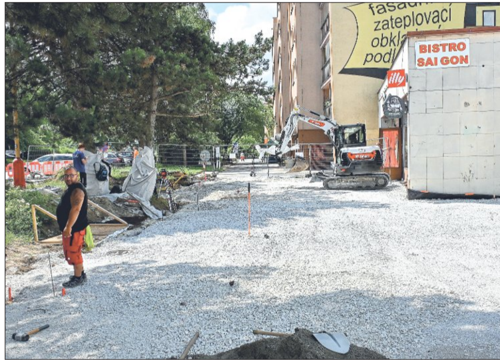
Úprava zpevněných ploch navazujících na Nové náměstí se zkomplikovala. Práce v horní části centra města by měly skončit do 23. července. FOTO: DAVID MACHÁČEK
