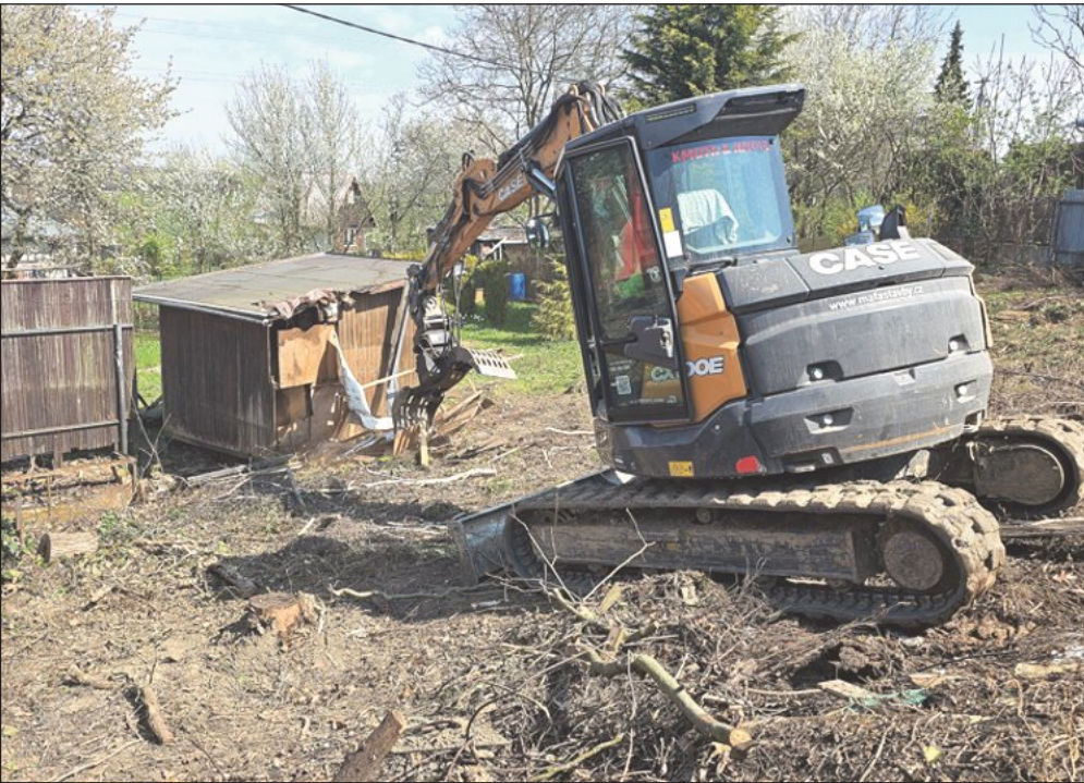
S koncem jara byla zahájena demolice objektů na území, kde má vzniknout mimoúrovňové napojení na budoucí D1. Samotné stavební práce se mají rozjet na podzim.
