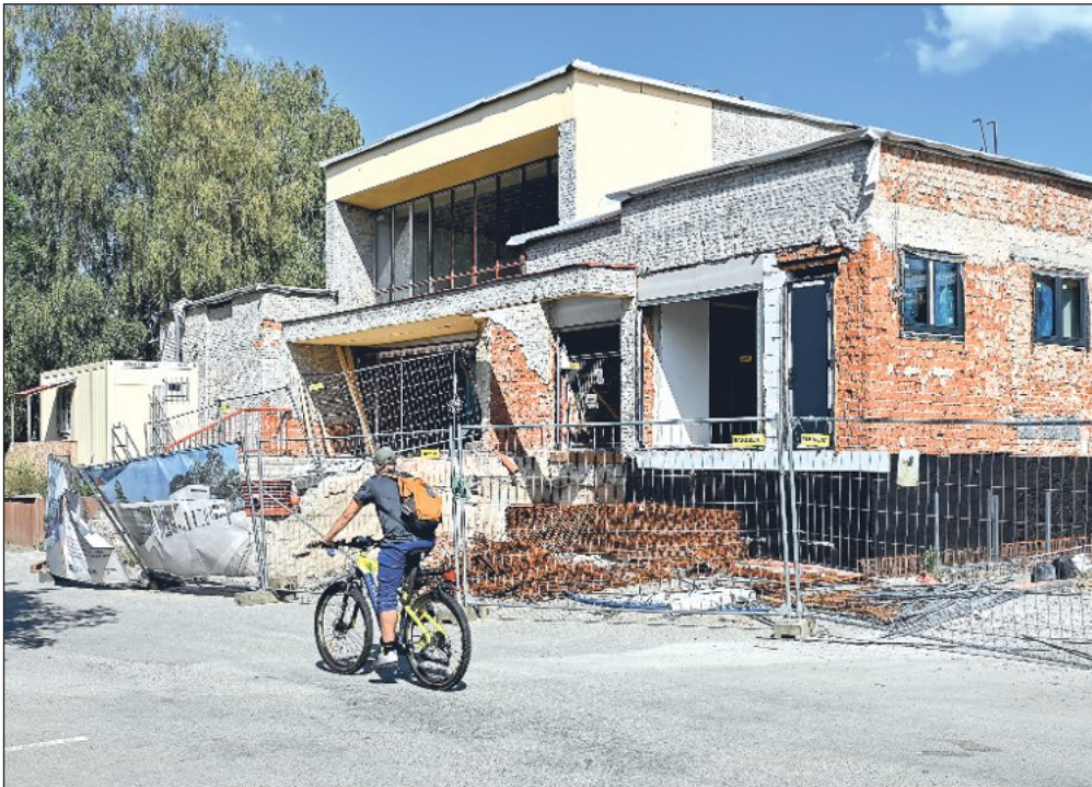
Rekonstruovaná nádražní budova v Kopřivnici nepůsobí dojmem brzkého dokončení. Termín jejího zprovoznění se už nyní posunul z října na leden příštího roku.
